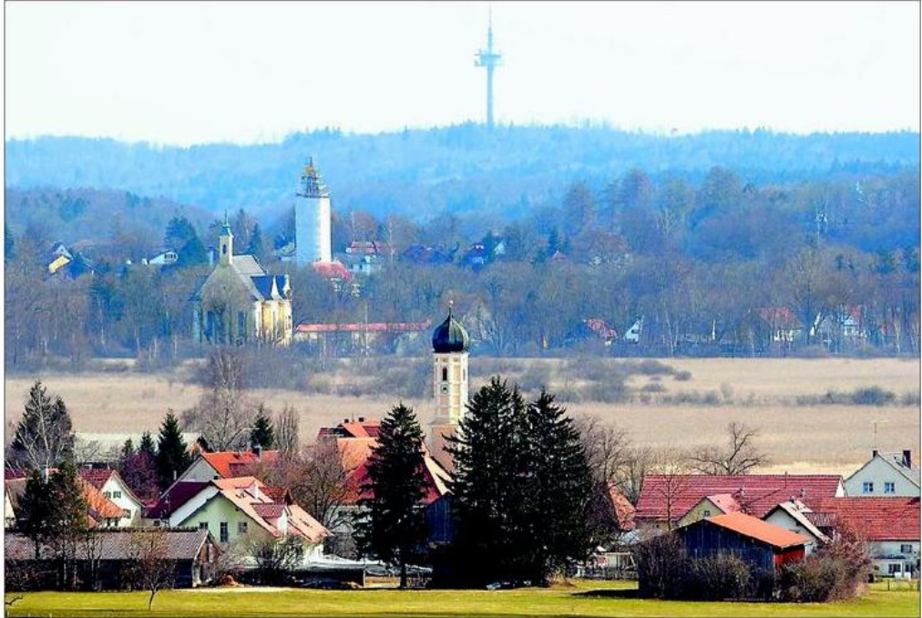
Entwässerungsgräben haben das Ampermoos immer mehr austrocknen lassen. Durch den Einbau einer Sohlschwelle zwischen Grafrath und Kottgeisering (Foto) soll der Grundwasserspiegel jetzt wieder angehoben werden.
