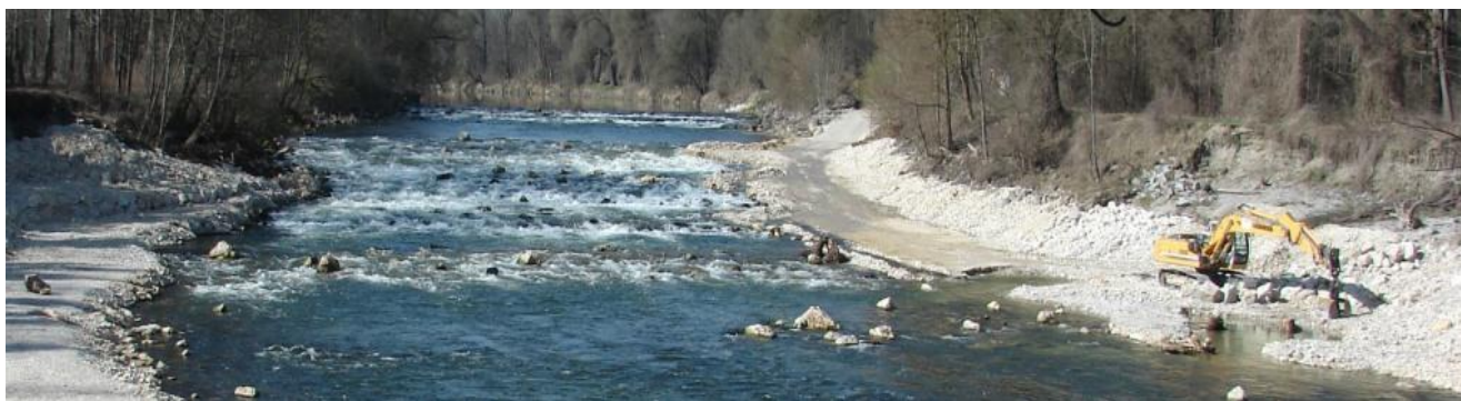
Foto: Kollsicherung und Wiederherstellung der Durchgängigkeit an der Sohlrampe bei Achering 2015
