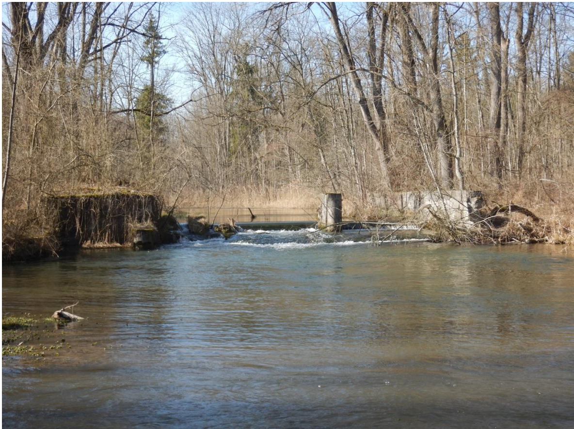
Abb. 2: Nicht durchgängiges Querbauwerk in der Dorfen bei Fkm 2,55
