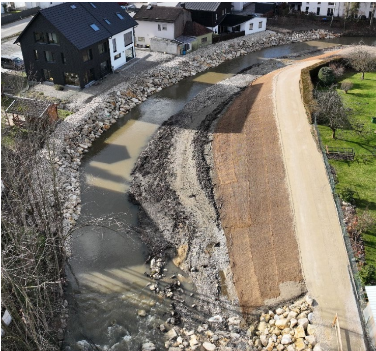
Vergößerung und Sicherung des Gerinnes (Drohnenaufnahme: WWA München)
